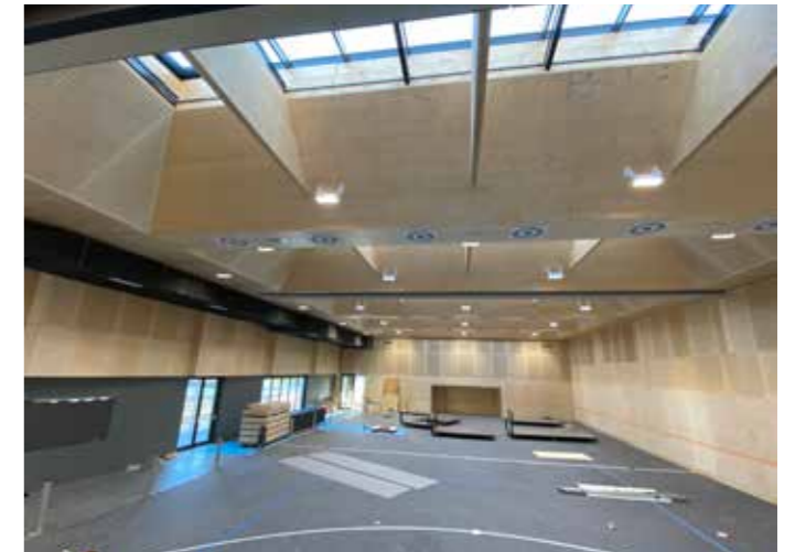
Der Blick von der Bühne lässt eine gutes Raumgefühl erahnen. Durch die versetzten Wandteile und die gelochten Holzpaneele entsteht die berechnete gute Akustik.
