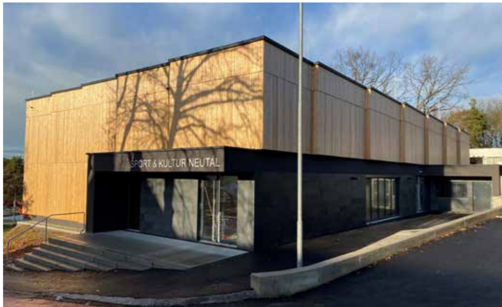
Unsere Sport- und Kulturhalle fügt sich harmonisch in den Bestand ein.
