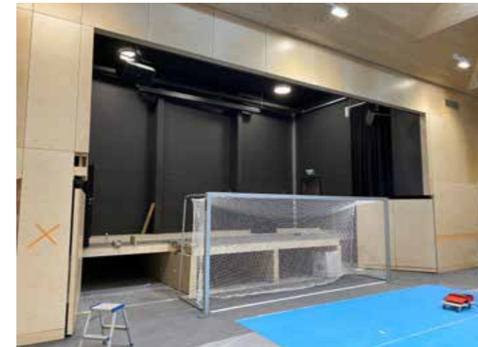
Mit einem ausgeklügelten System lässt sich die Kulturhalle mit dem Bühnenbereich zu einer Sporthalle mit Fußballtoren umbauen.
