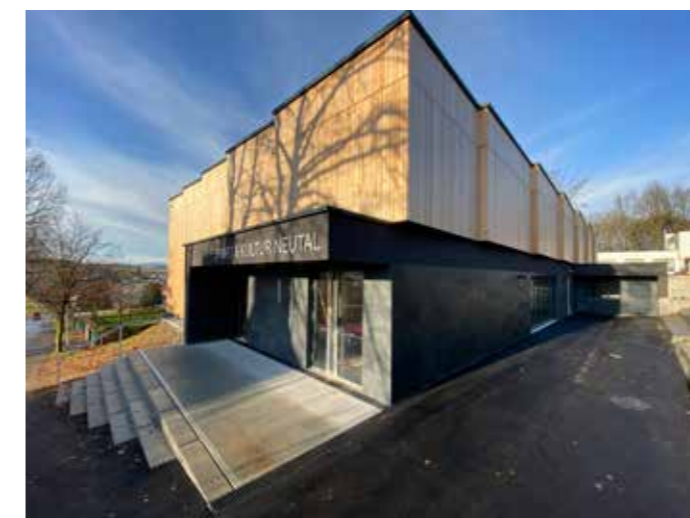
Die Halle ist mit einer Faltschiebetür zum Vorplatzbereich samt Sitzstufen zu öffnen, um bei Veranstaltungen auch den Außenbetrieb gut miteinzubeziehen zu können.
